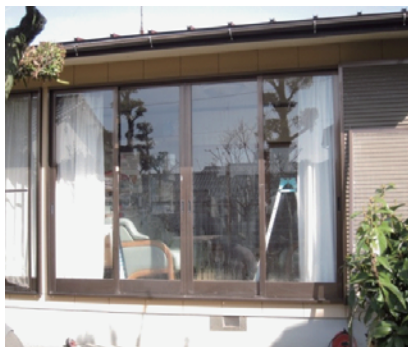
サッシの修理・交換
